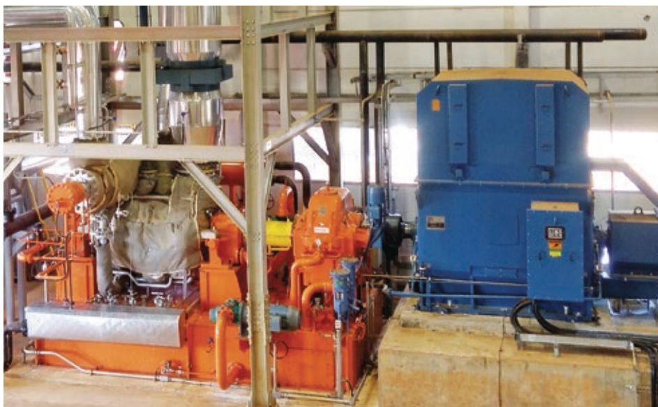
TURBOGERADOR EM OPERAÇÃO EM MATO GROSSO
